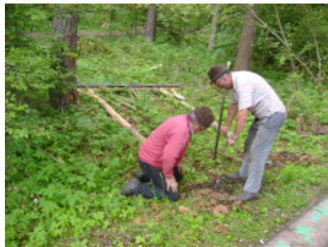
beim Instandsetzen des Walderlebnispfades
